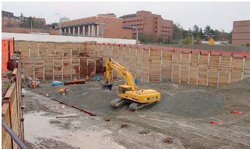
การขุดดินเพื่อก่อสร้างอาคารขนาดใหญ่ที่มีการอนุญาตตามกฎหมายว่าด้วยการควบคุมอาคาร และได้มีมาตรการป้องกันอันตรายไว้แล้ว
